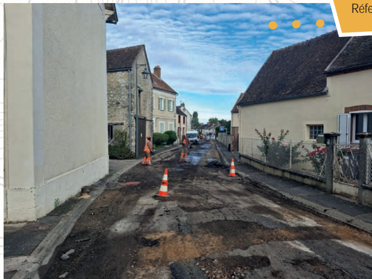
DIANT Hameau de Cornoy Réfection voirie - Enrobé coulé à froid
