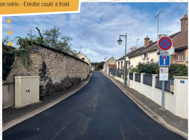
DIANT Hameau de Cornoy Réfection voirie - Enrobé coulé à froid
