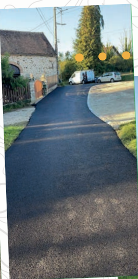
DIANT Hameau de Cornoy Réfection voirie - Enrobé coulé à froid
